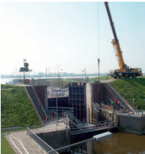
Trockenlegung des Außenhauptes, 2005
