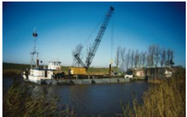
Abb. 5 Einbringen der Spundwandbohlen am Aussenhaupt, Profil Larssen 430, Länge 25,5 m
