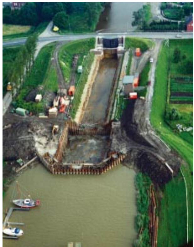
Abb. 10 Fertiggestellte Baugrube für den Neubau des Aussenhauptes
