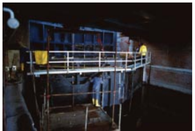
Abb. 20 Einbau der instandgesetzten Ebbetore am Binnenhaupt
