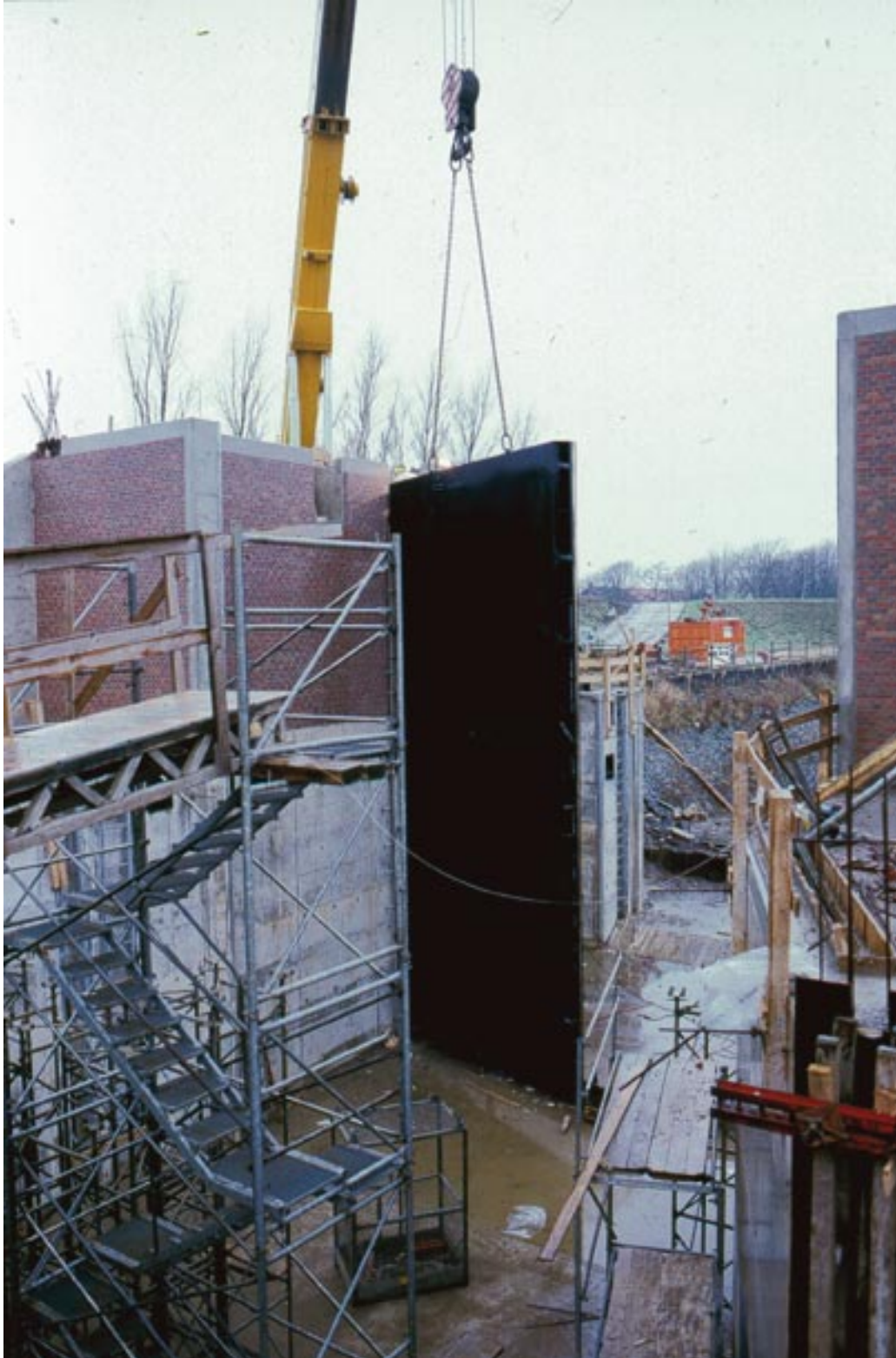
Abb. 16 Einbau des Fluttorepaares am fertiggestellten neuen Aussenhaupt
