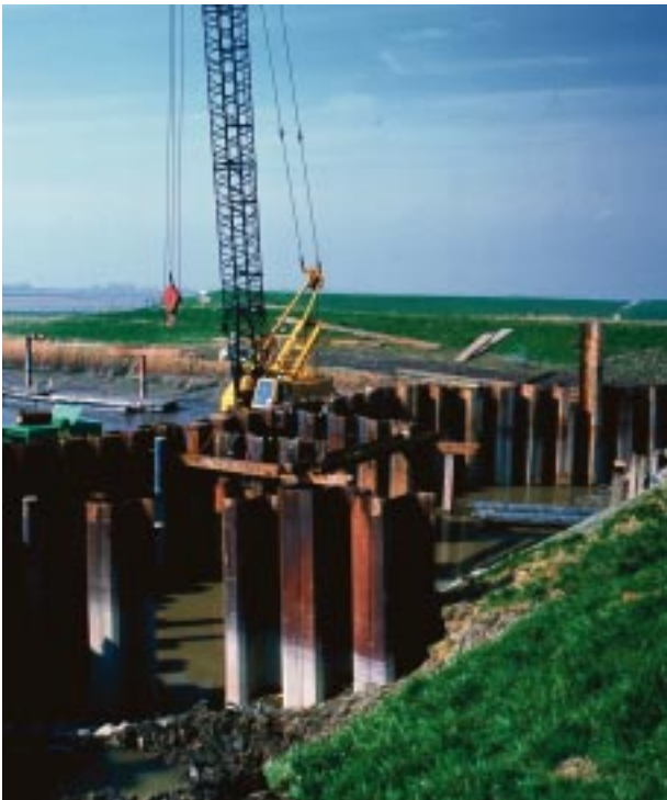
Abb. 9 Umbau der Hochwasserschutzwand am Aussenhaupt
