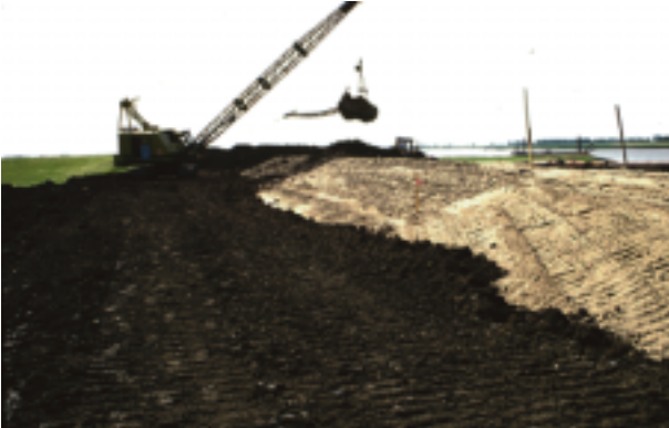
Abb. 23 Profilierter Sandkern mit Kleiabdeckung
