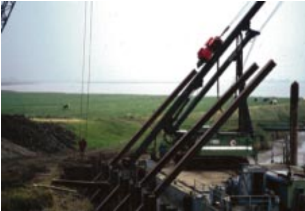
Abb. 17 Rammen der Flügelspundwände im Vorhafen
